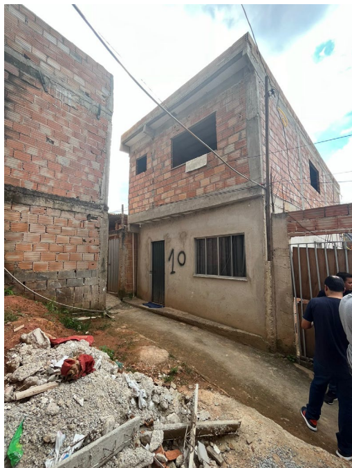
Fachada frontal do imóvel, no dia 10/04/2024. Fonte: acervo da equipe.
