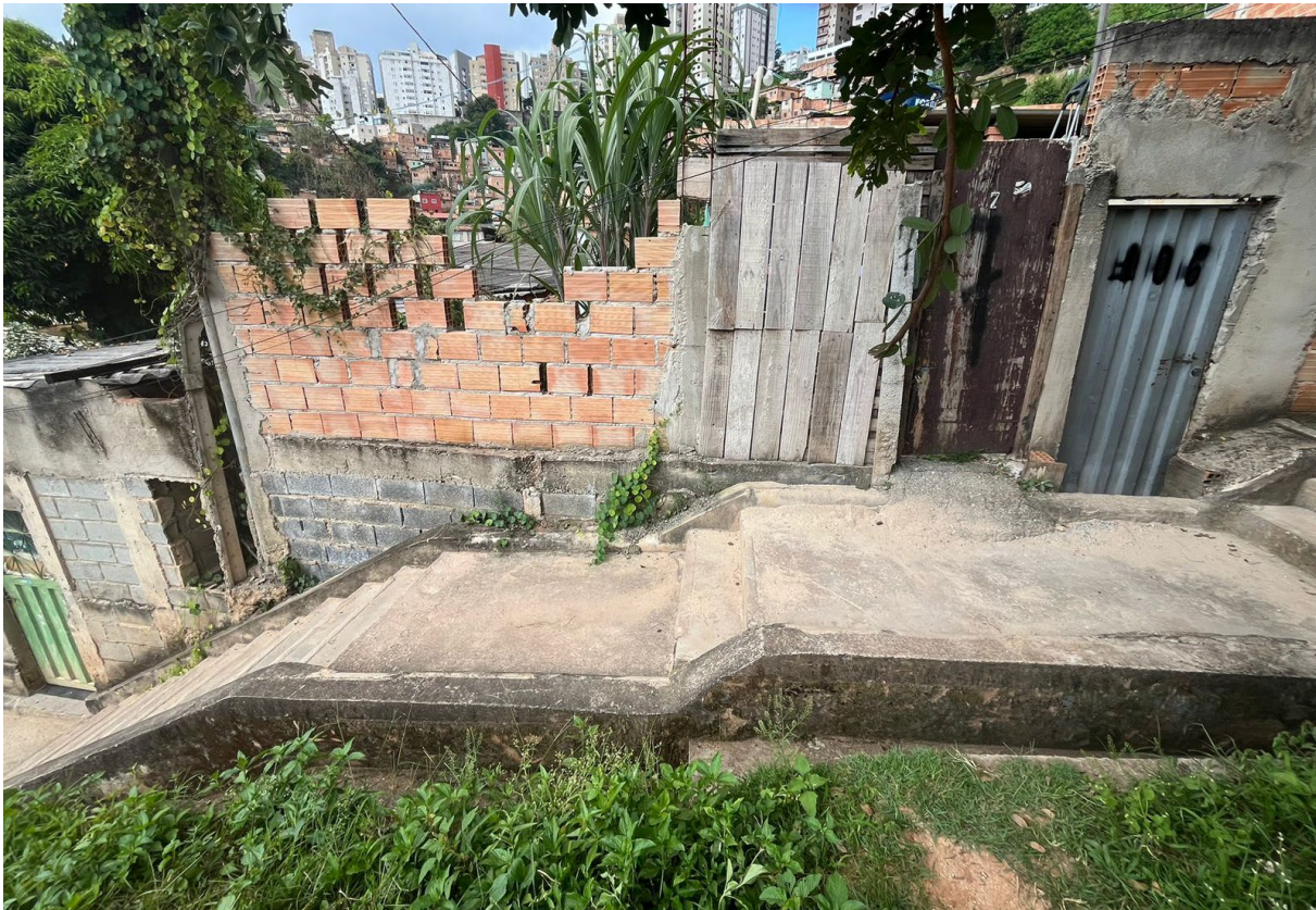
Fachada frontal do imóvel, no dia 10/04/2024. Fonte: acervo da equipe.
