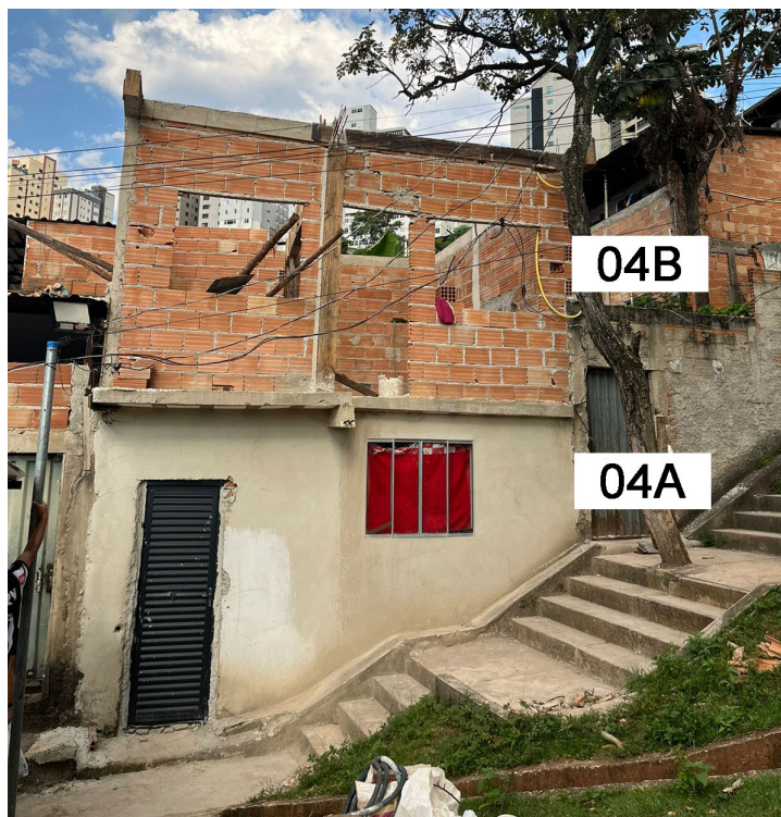
Fachada frontal do imóvel, no dia 10/04/2024. Fonte: acervo da equipe.
