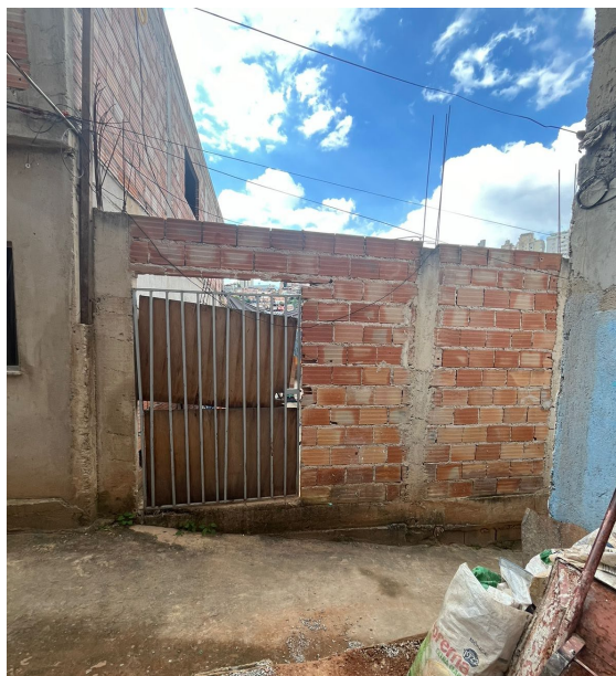
Fachada frontal do imóvel, no dia 10/04/2024. Fonte: acervo da equipe.
