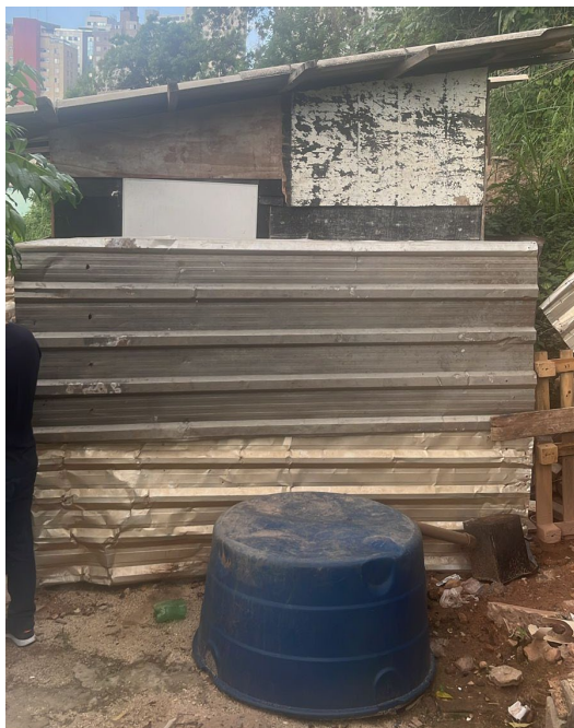
Vista lateral do imóvel, no dia 10/04/2024. Fonte: acervo da equipe.
