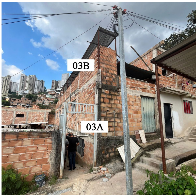
Fachada frontal do imóvel, no dia 10/04/2024. Fonte: acervo da equipe.
